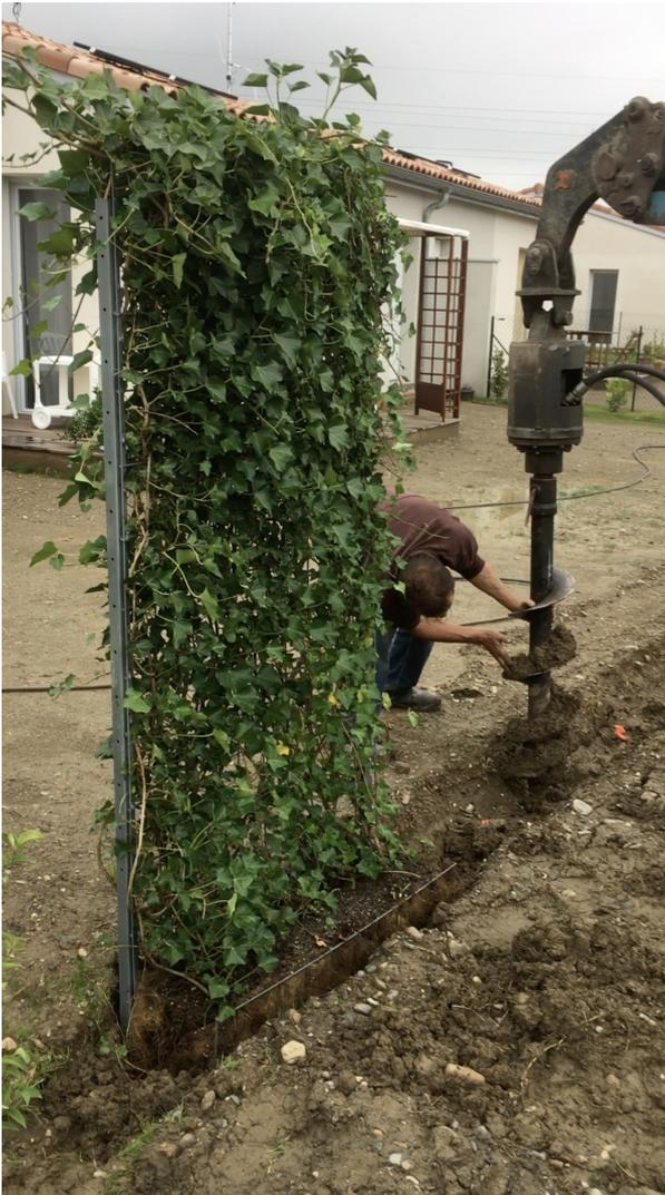
1) Réalisation d'une tranchée de 0,30m de large jusqu'à 0,40m suivant la cohésion du sol en place. La profondeur de cette tranchée sera de 0,25m de façon à ce que le module soit 3 cm plus bas que le niveau du sol en place.
